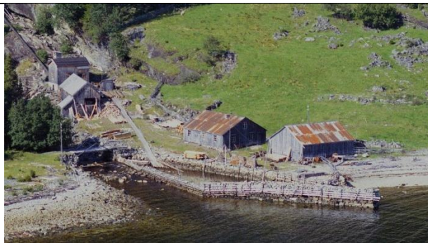
Foto: Widerø, fra før veien fra Leksvik til Vanvikan delte anlegget
