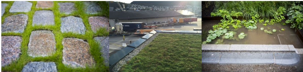
Figur 27: Fra venstre: permeabelt dekke, grønt tak, regnbed. Alle er eksempler på lokal overvannsdisponering.
