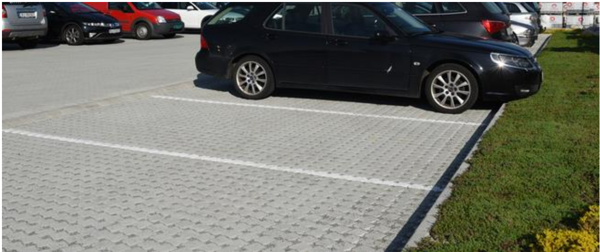
Permeable dekker på parkeringsareal (Multiblokk)
