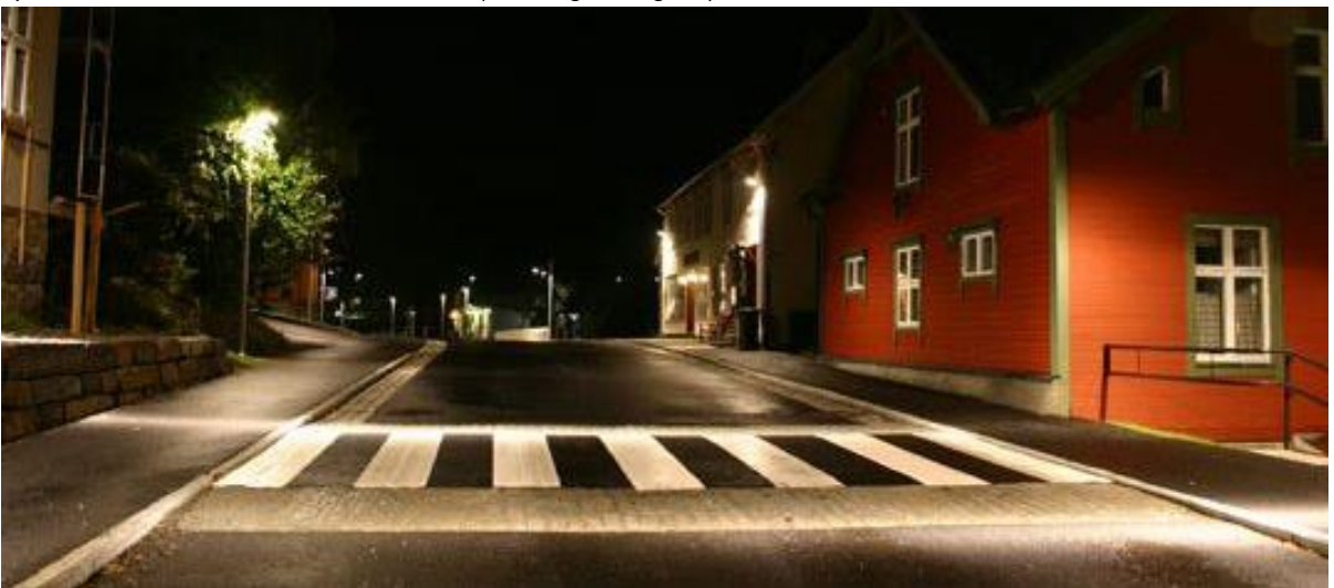
Lyssetting av fotgjengerovergang i Tingvoll (Miljøverndepartementet)
