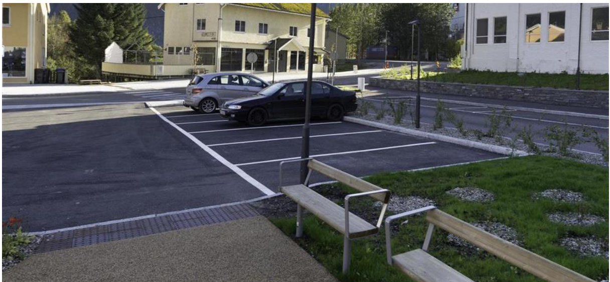
Gangsoner og oppmerket parkeringsareal, Glomfjord sentrum (Nordland Fylkeskommune)
