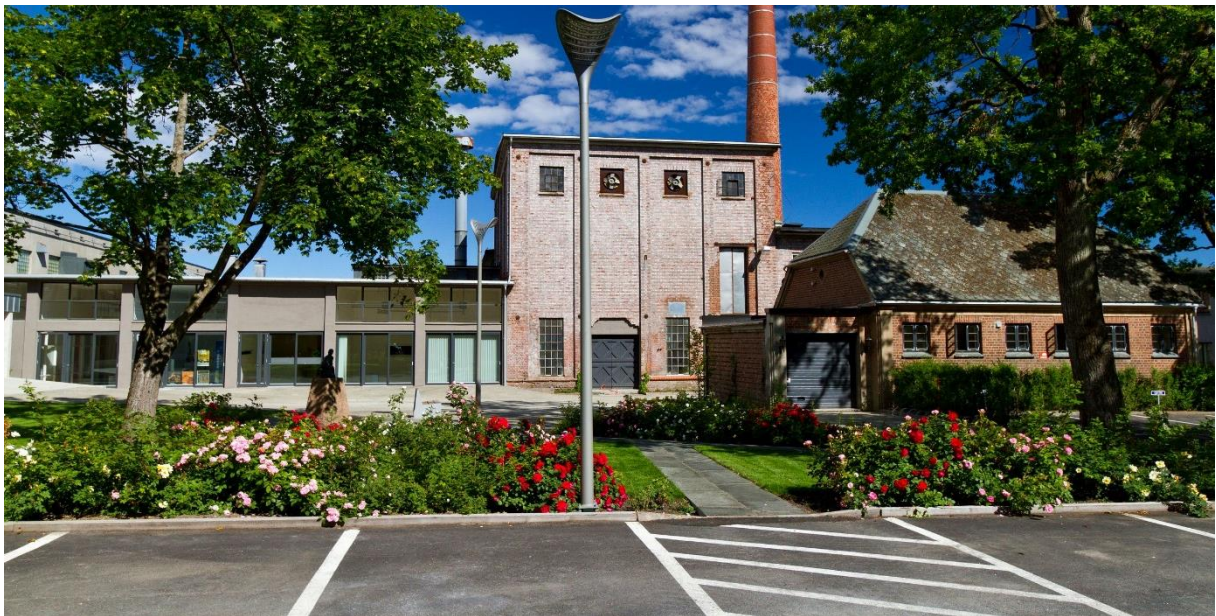
Fotgjengersone med grøntareal ved parkeringsareal, Agnes torg, Stavern (Dronninga landskap)
